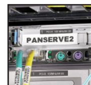
Repérage des infrastructures réseaux
